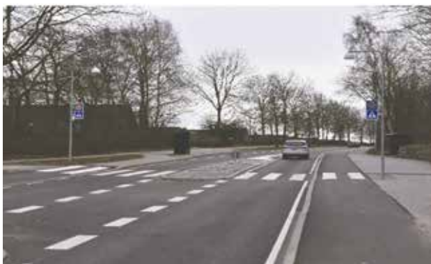
Ombygning af krydsning på Rønnebær Allé
